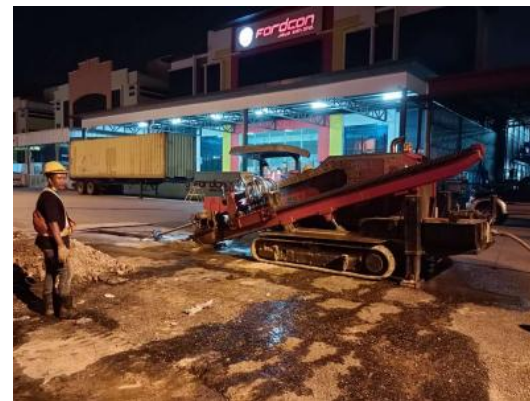
Kerja HDD Bagi Menaiktaraf Pembekalan Tenaga Elektrik Di Pak Tam Katering Sdn. Bhd.
